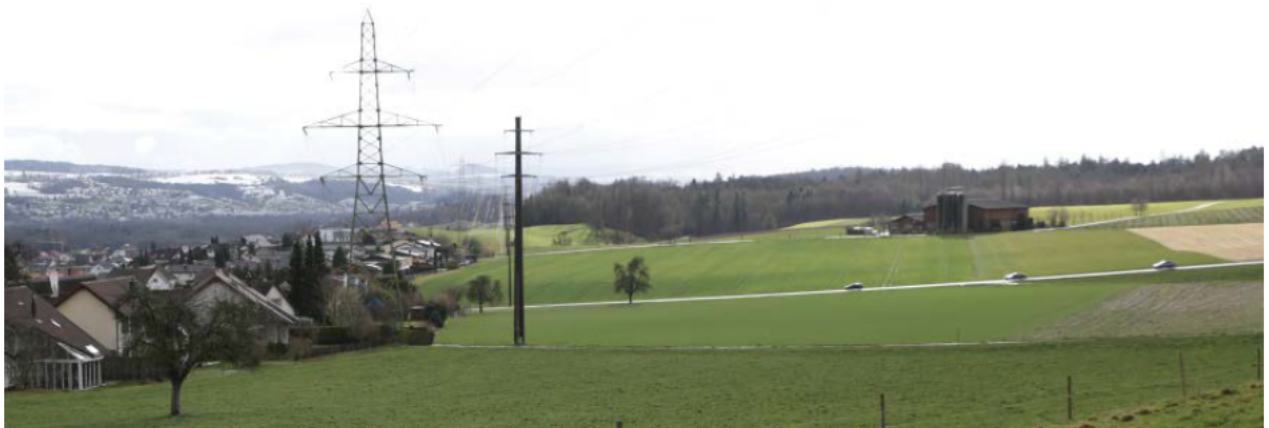
Abbildung 2: Gemeindegemeinde von Niederwil mit bestehender 220-kV- und 50-kV-Freileitung sehr nahe dem Siedlungsgebiet. Die 50-kV-Leitung wird derzeit durch eine 110-kV-Kabelanlage ersetzt.
