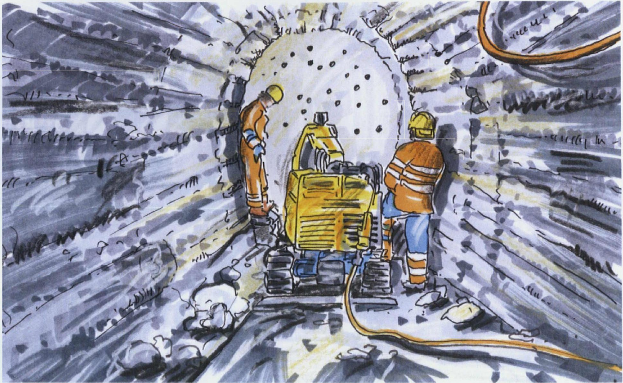
Abbildung 19: Bau eines Tunnels für eine Kabelleitung. Zuerst werden Löcher gebohrt, mit Sprengladungen gefüllt und dann wird gesprengt. Im Anschluss an die Sprengung muss das ausgebrochene Material abtransportiert werden.
