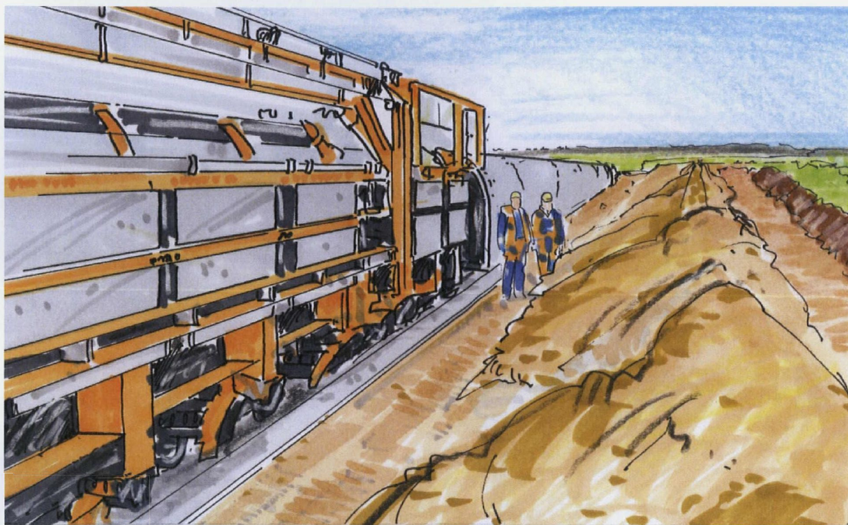
Abbildung 11: Bau eines Infrastrukturkanals nach der Methode Dupré
