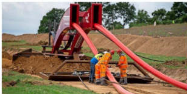
Bearbeiter vor dem Mehrfachpflug zur Verlegung von Stäbkabeln. Quelle: Foto: Christophe Bateau/Alfa
