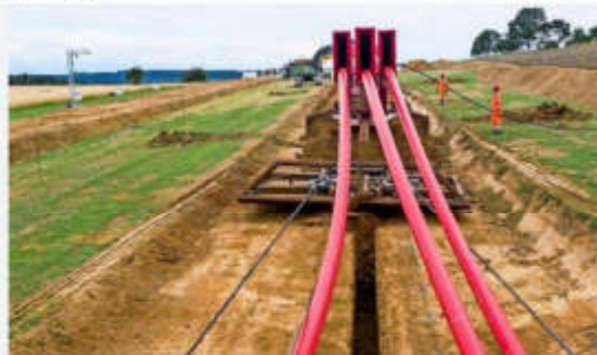
Mit dem Kabelpflug werden Rohre für Erdkabel unter die Erde gebracht. Der Netzbetreiber Tennet erhofft sich die weite Akzeptanz für den Netzausbau.
