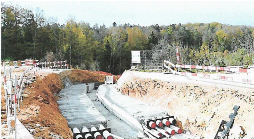
Abb. 1: Erdverkabelung nach SIA Norm 1, Quelle: Bauernzeitung
